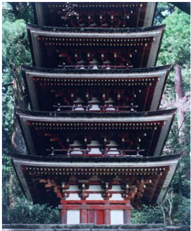
3. 室生寺五重塔見上げ
